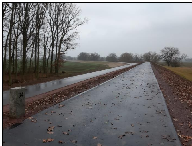
Abbildung 2: DIN gerechter Deichkörper (Abnahme am 15.12.2021)
